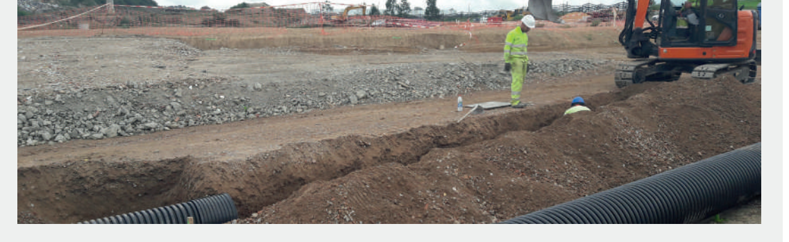
ASENTAMIENTO DE CONDUCCIONES CON FINO DE PLANTA RCD
