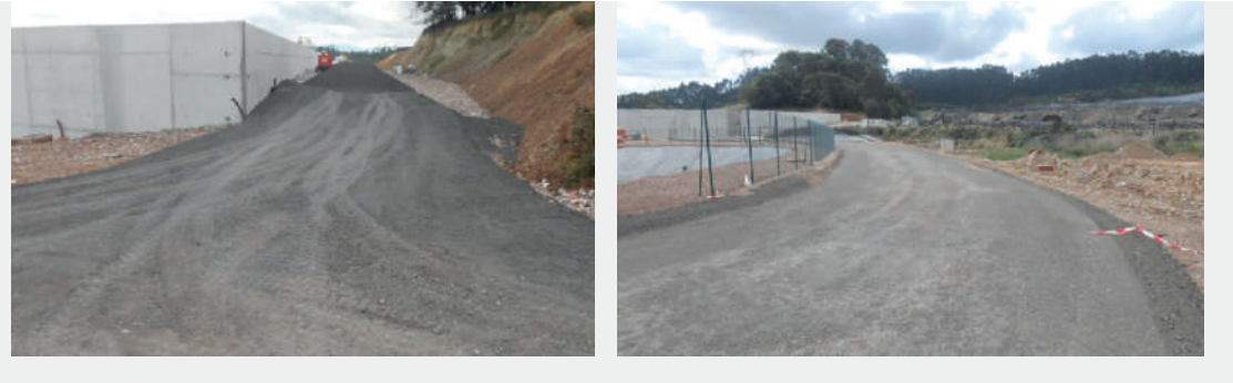
VIALES EN VERTEDERO DE RESIDUOS NO PELIGROSOS CON ÁRIDO 0-32 ORIGEN MB
