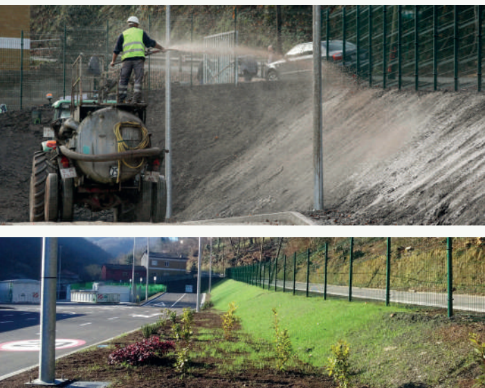
TALUD DE PUNTO LIMPIO CON HYDRORECYSOIL
