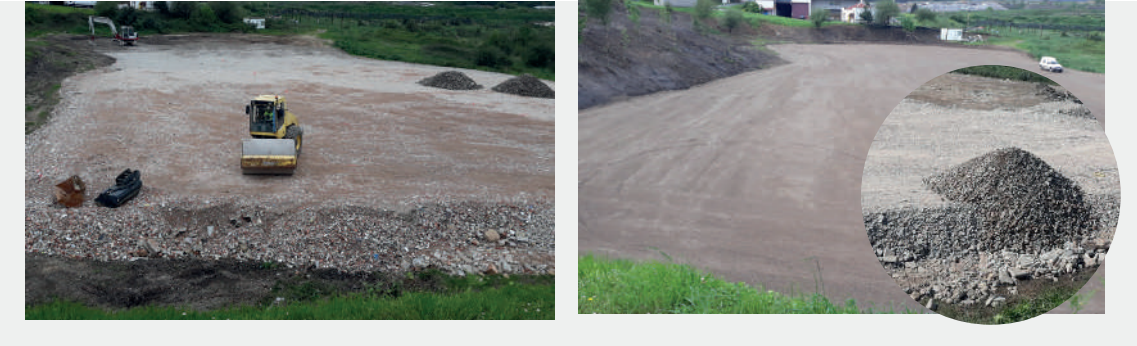
EXPLANADAS. RELLENO PEDRAPLÉN DISTINTOS ÁRIDOS (MIXTOS Y HORMIGÓN)
