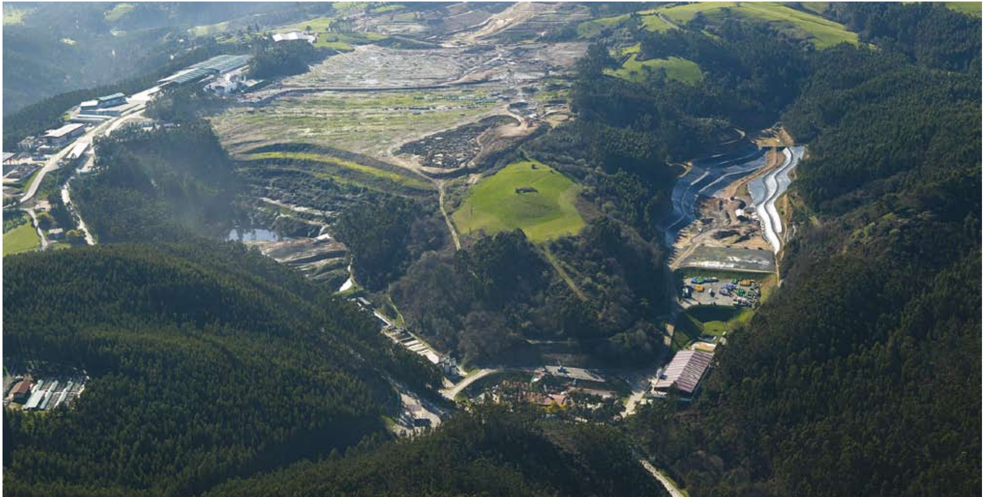
Centro de Tratamiento de Residuos de COGERSA
