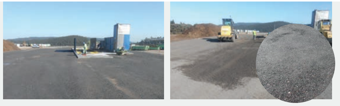
CAPA DE BASE EN VIALES VERTEDERO DE RESIDUO NO PELIGROSOS CON ÁRIDO DE ORIGEN MB
