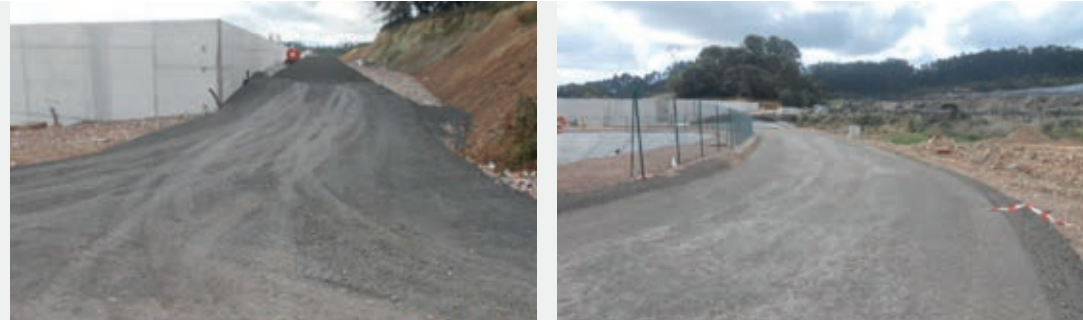
VIALES EN VERTEDERO DE RESIDUOS NO PELIGROSOS CON ÁRIDO 0-32 ORIGEN MB
