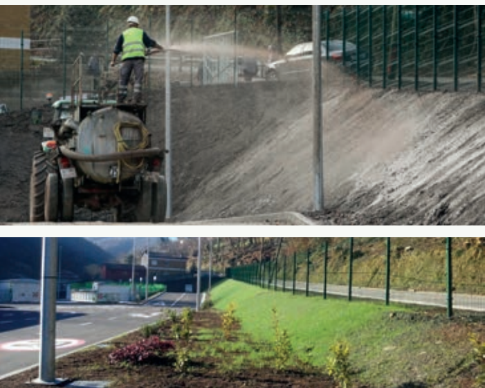
TALUD DE PUNTO LIMPIO CON HYDRORECYSOIL
