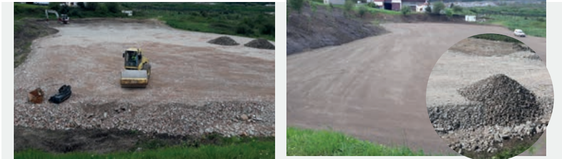
EXPLANADAS. RELLENO PEDRAPLÉN DISTINTOS ÁRIDOS (MIXTOS Y HORMIGÓN)
