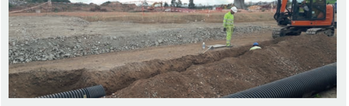
ASENTAMIENTO DE CONDUCCIONES CON ÁRIDO 0/20
