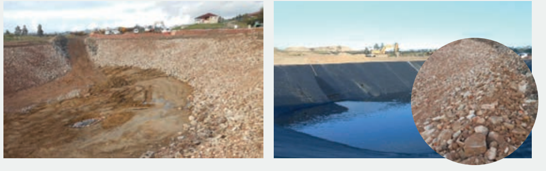
CREACIÓN DE FIRME DE Balsa DE LIXIVIADOS SOBRE RESIDUO CON ÁRIDO MIXTO
